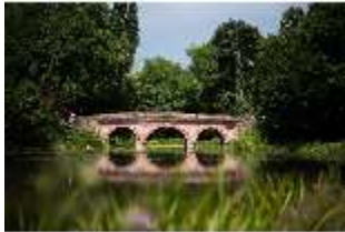
Schb.V, Rote Brücke über den Unteren See, DI028123, BSV-
