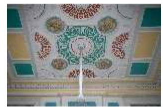
Schb.II, Decke, Saal, 1. OG, R. 8, DI028266, BSV-
