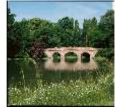
Schb.I, Rote Brücke (10), DE001204, BSV-
