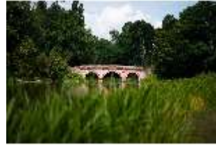
Schb.V, Rote Brücke über den Unteren See, DI028102, BSV-
