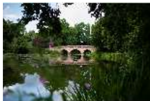
Schb.V, Rote Brücke über den Unteren See, DI028129, BSV-
