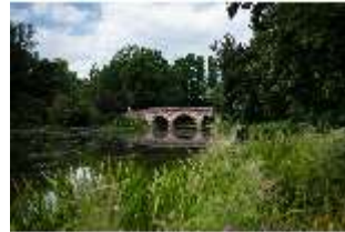
Schb.V, Rote Brücke über den Unteren See, DI028126, BSV-
