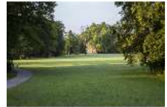
Schb.V, Nordfassade vom Park aus gesehen, DI006758, BSV
