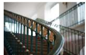
Schb.II, Detail Geländer, Treppenhaus, R. 6, DI028258, BSV-
