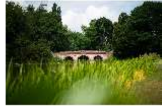
Schb.V, Rote Brücke über den Unteren See, DI028103, BSV-
