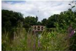
Schb.V, Rote Brücke über den Unteren See, DI028125, BSV-
