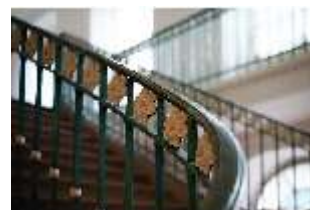
Schb.II, Detail Geländer, Treppenhaus, R. 6, DI028257, BSV-
