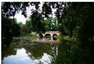
Schb.V, Rote Brücke über den Unteren See, DI028128, BSV-
