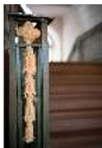
Schb.II, Detail Geländer, Treppenhaus, R. 6, DI028256, BSV-
